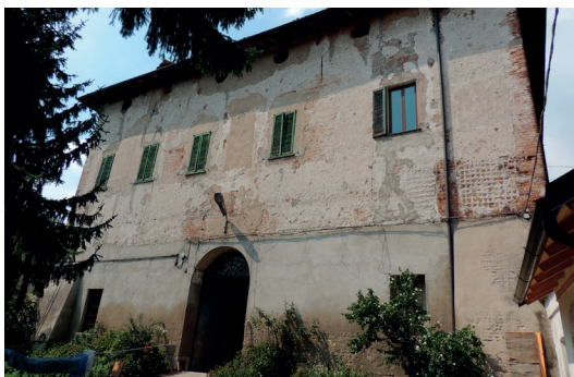
Il fronte sud, che presenta l'ingresso principale all'edificio, affaccia sulla corte principale di C.na Castello ed è caratterizzato da un aspetto più severo.
